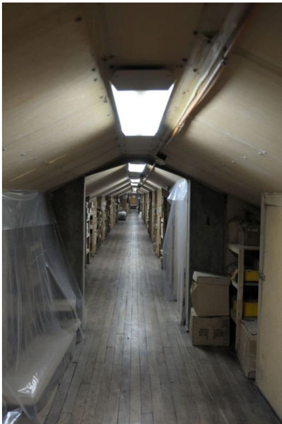
Entretecho 5° piso ala poniente, depósito del área de Antropología.
